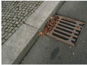
배수구, 하수관거 등 배수시설 점검
